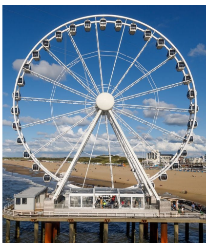
Figure 1 – Exemple de translation circulaire. Les cabines dans lesquelles montent les passagers d'une grande roue ont un mouvement de translation circulaire : le passager reste toujours à la verticale !
